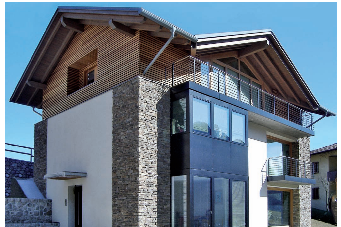
BU: Verschiedene Profilierungen sowie die waagerechte oder senkrechte Verlegung oder eine Kombination aus beidem sorgen für eine interessante Fassadengestaltung. Bild: tdx/GD Holz e.V./Ahrntaler Farina
